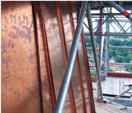
Die Erneuerung wurde nötig, weil bei der Sanierung in den 1990er Jahren zu großformatige Bleche verwendet wurden und die alte darunter befindliche Holzunterkonstruktion nicht mit erneuert wurde. Sie war schlichtweg vergammelt. Folglich hielten die Bleche nicht mehr richtig und bei zu viel Wind kam unerwünschte Bewegung ins Spiel.
